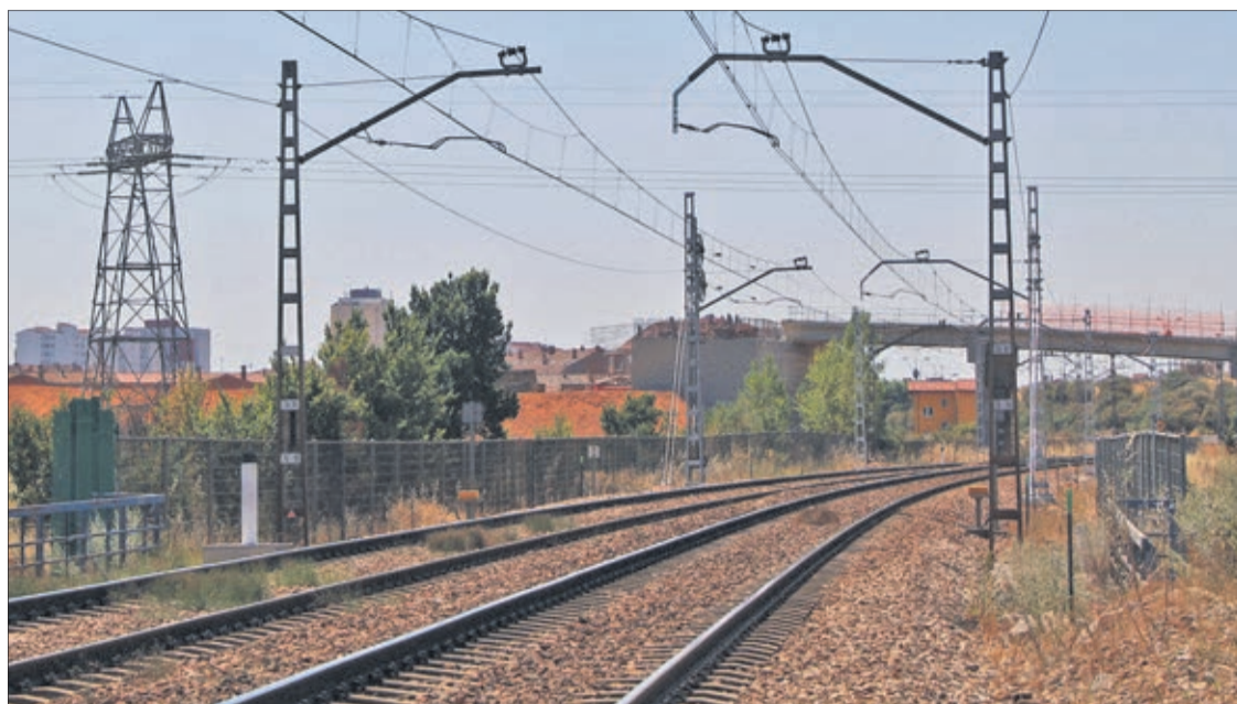
El paso elevado del nuevo vial enlaza la rotonda de San Juan de Dios con la del Ayuntamiento de San Andrés y salva las vías del ferrocarril.
