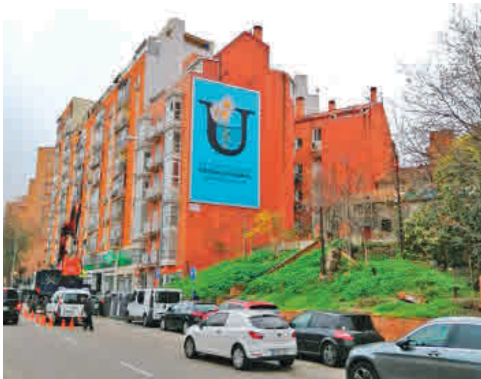
Uno de los carteles instalados en un edificio de la avenida de Córdoba, 8
