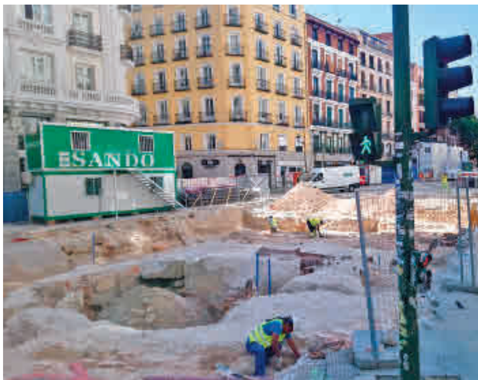
Los trabajos de remodelación en la calle de Montera
