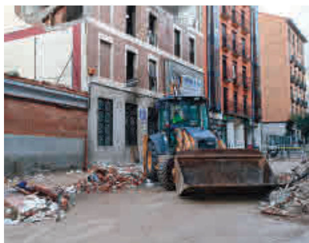
El desmontaje del edificio empezó el 25 de enero
