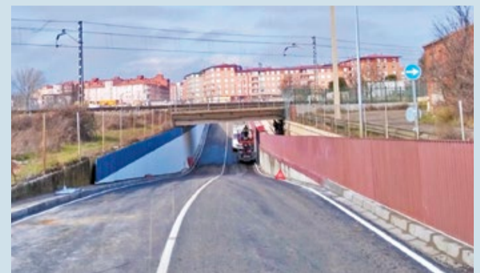
Las obras de la calle Príncipe se enmarcan en el proyecto de permeabilidad.
