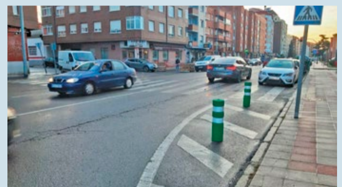
Las balizas se han instalado en los puntos con mayor riesgo de siniestro.
