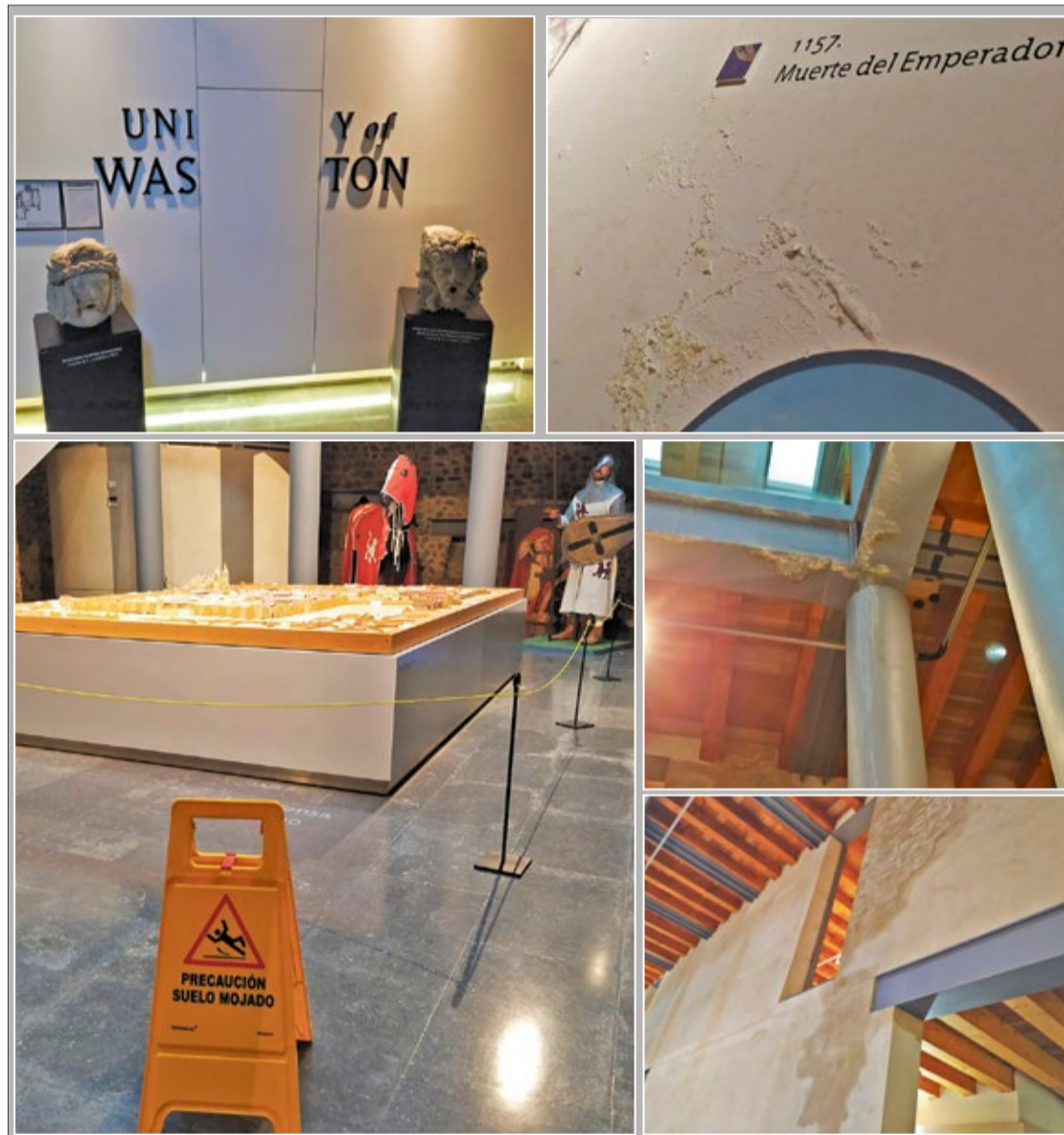
Imágenes del estado del Palacio del Conde Luna, con paredes con humedades, descascarilladas, goteras, letras caídas...
