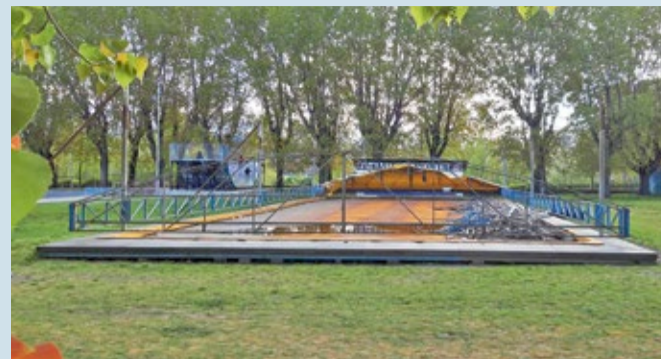
La pista de coches de choque de Papalaguinda ya está desmantelada.
