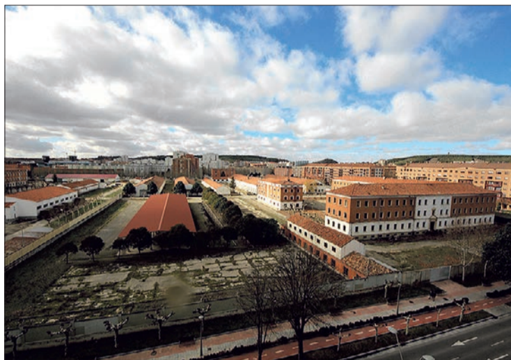
Imagen de archivo del antiguo Parque de Artillería. Los edificios ya han sido demolidos.
