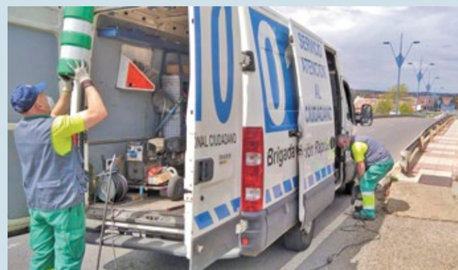
La Brigada de Intervención Rápida se encargó de colocar las balizas.
