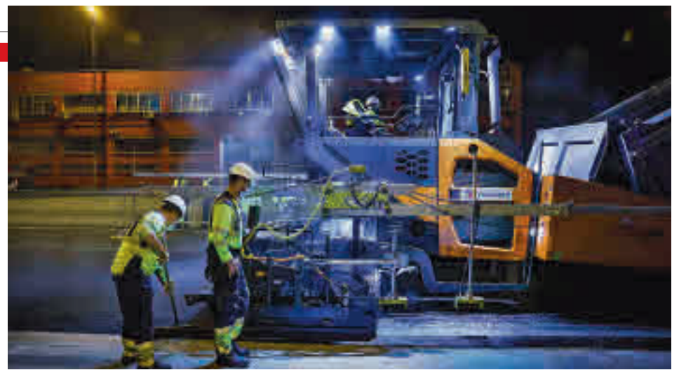
Trabajos sobre la calzada de la M-506
