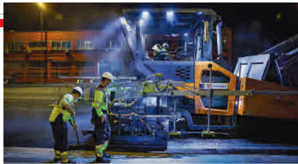
Trabajos sobre la calzada de la M-506
