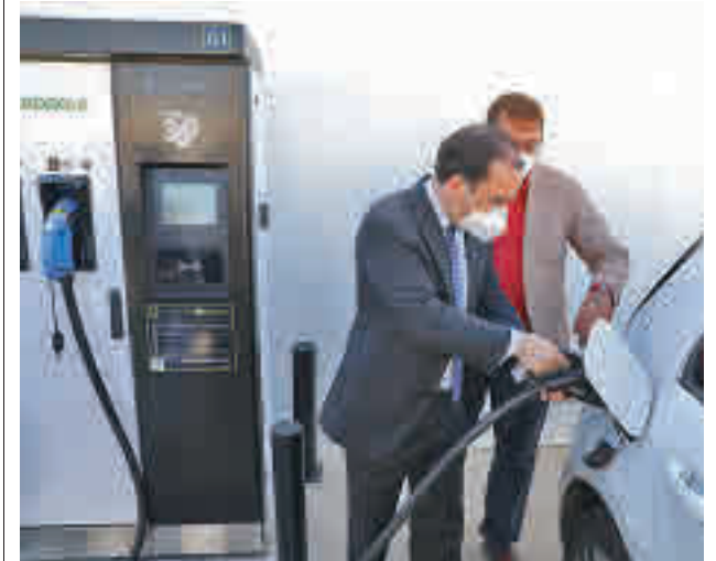
Carabante comprueba el funcionamiento de la instalación
