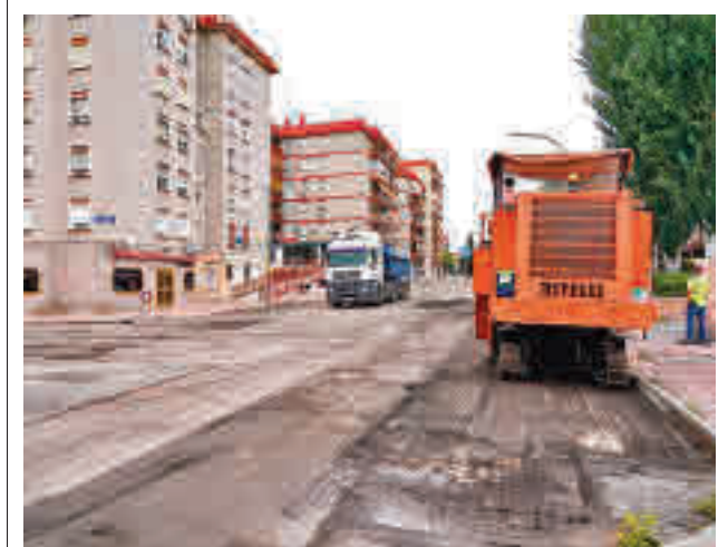
Máquinas actuando sobre el firme de Móstoles
