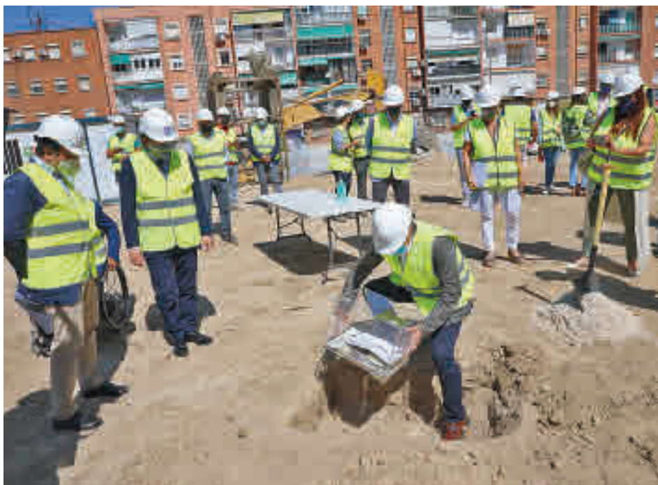
Un momento de la colocación simbólica de la primera piedra
