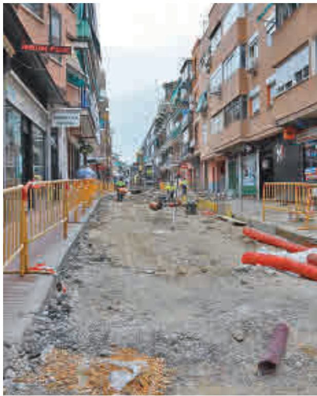
Obras en las calles de Getafe
