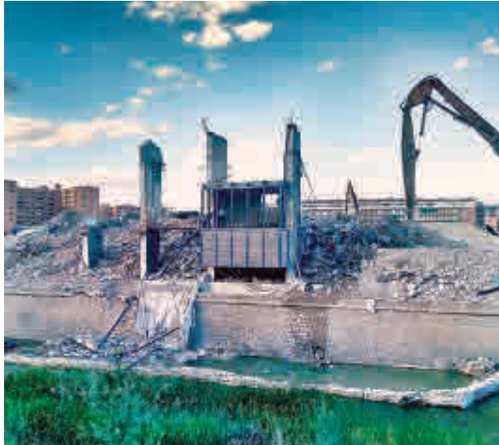
Los trabajos de desmontaje del Vicente Calderón
