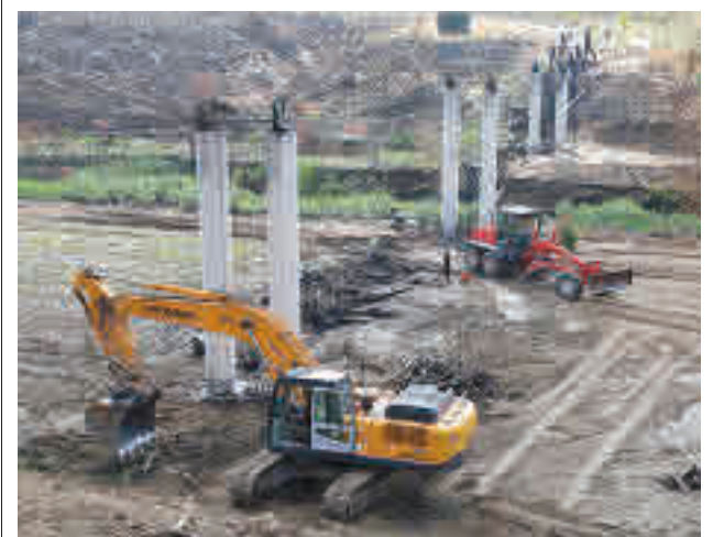
Primeros trabajos en la pasarela
