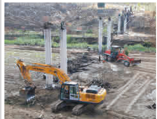
Primeros trabajos en la pasarela
