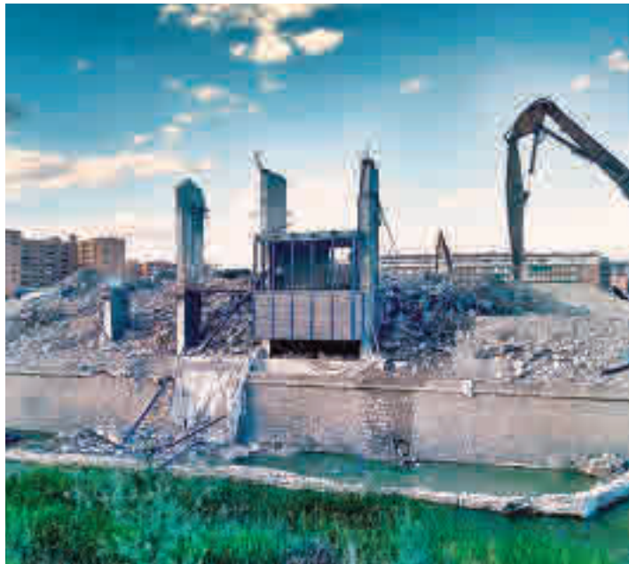
Los trabajos de desmontaje del Vicente Calderón
