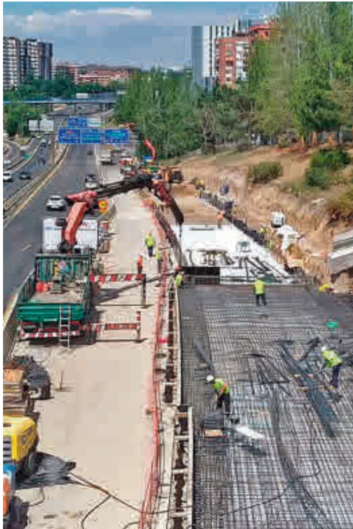
Varios operarios realizan trabajos en la zona de actuación
