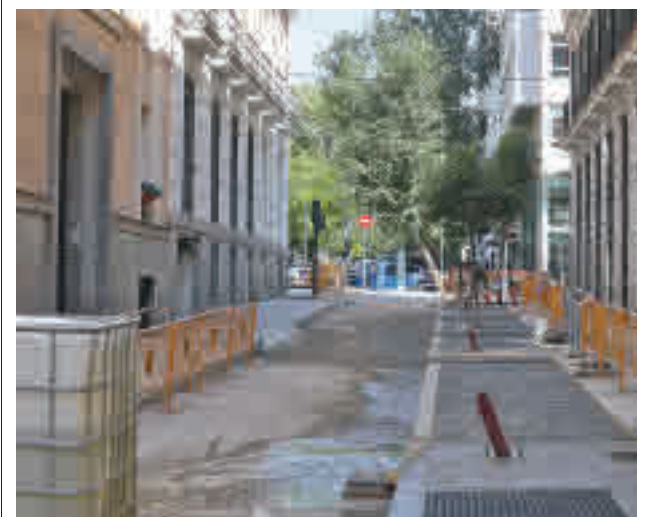
Los trabajos en una de las calles de la operación
