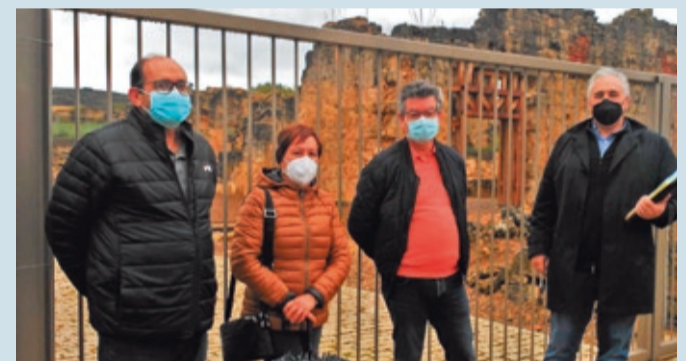
También se ha iniciado la obra de consolidación de muros en San Pedro de Eslonza.
