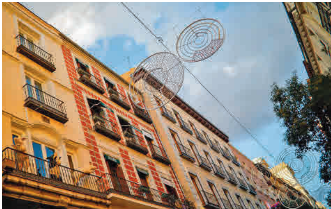
El Consistorio de la capital ha iniciado ya los trabajos de instalación de los motivos navideños
