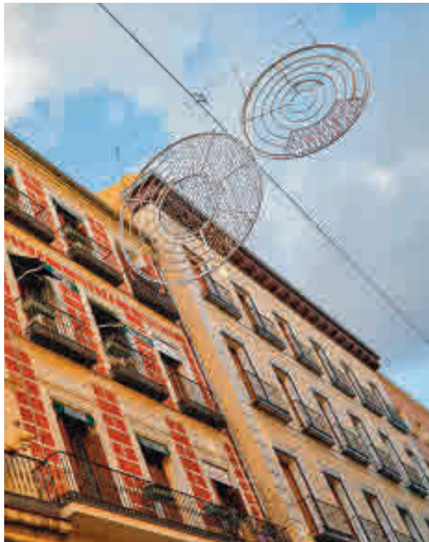
El Consistorio ha iniciado ya los trabajos de instalación
