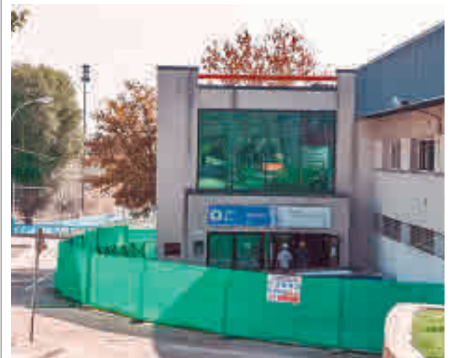
Estado actual de las obras
