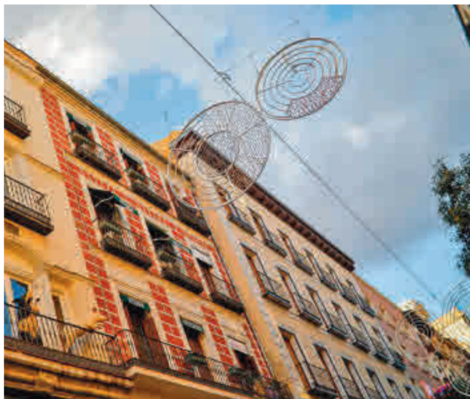
El Consistorio de la capital ha iniciado ya los trabajos de instalación de los motivos navideños
