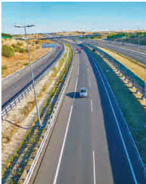
Paso de la M-50 por Perales del Río
