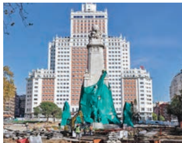
Las obras en el entorno de Plaza España
