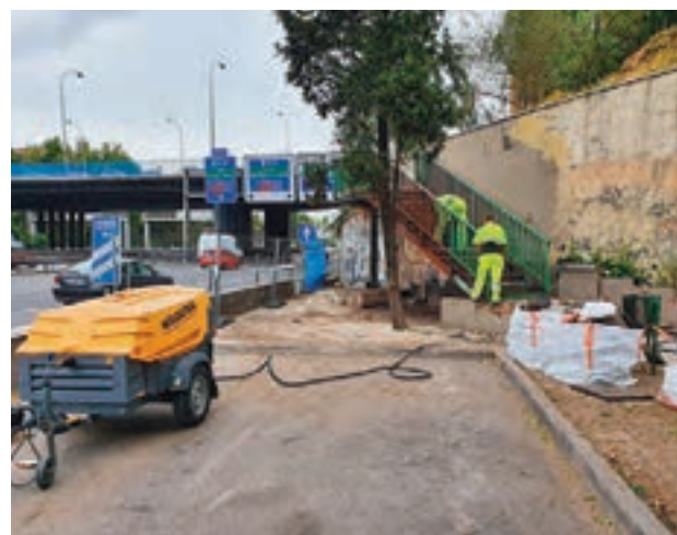
Los trabajos de desmontaje de la infraestructura
