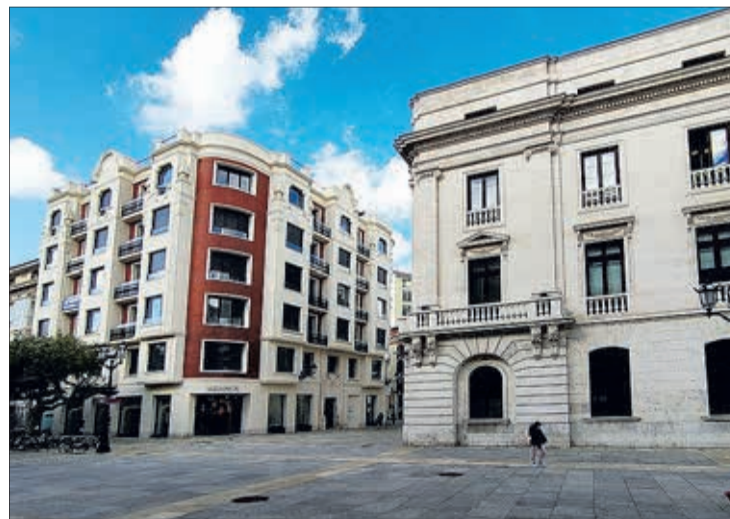
El edificio del antiguo Hotel España, en el Paseo del Espolón, tras su remodelación.
