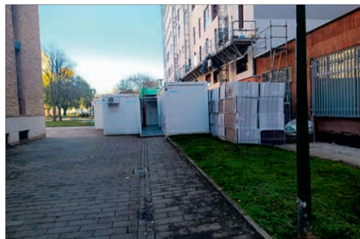
Exterior del centro de Salud de García Lorca.
