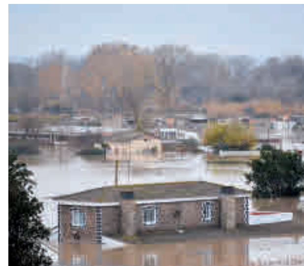
El clima hace estragos en las viviendas
