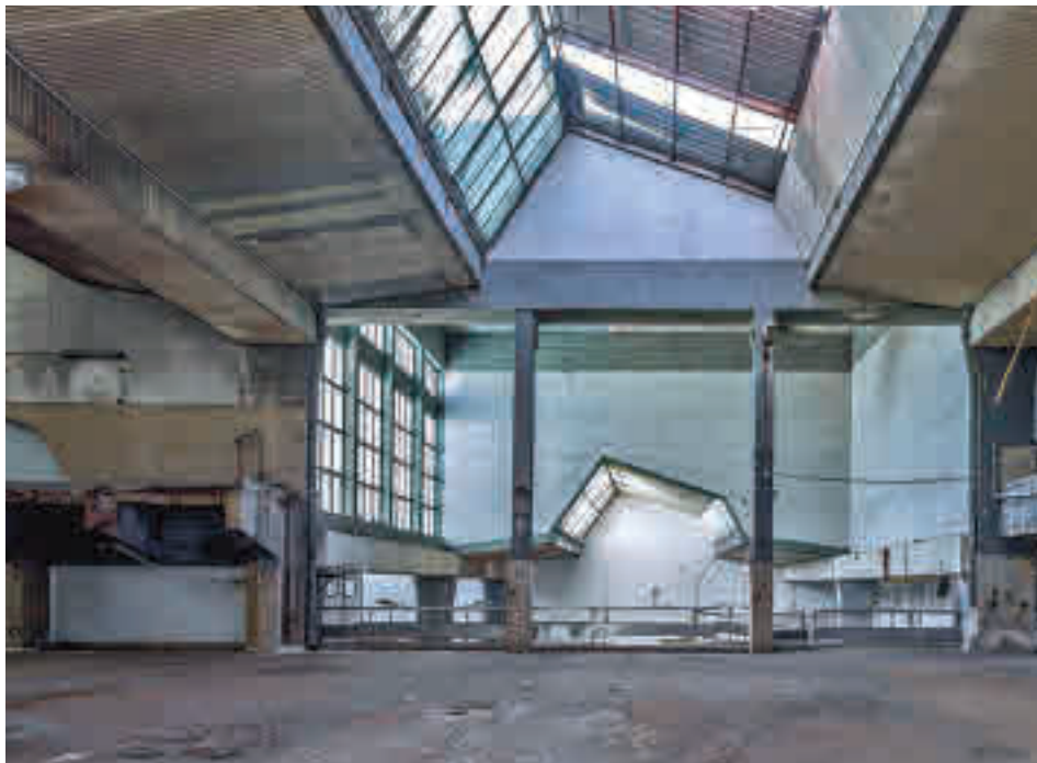
El interior de la antigua industria lechera FUNDACIÓN ALEJANDRO DE LA SOTA
