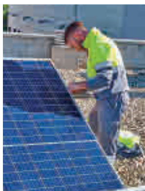
Instalación de placas solares
