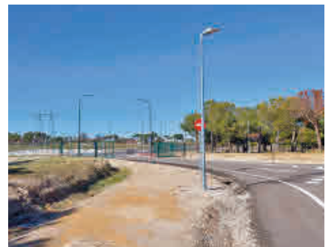
Obras en el Parque Adolfo Suárez
