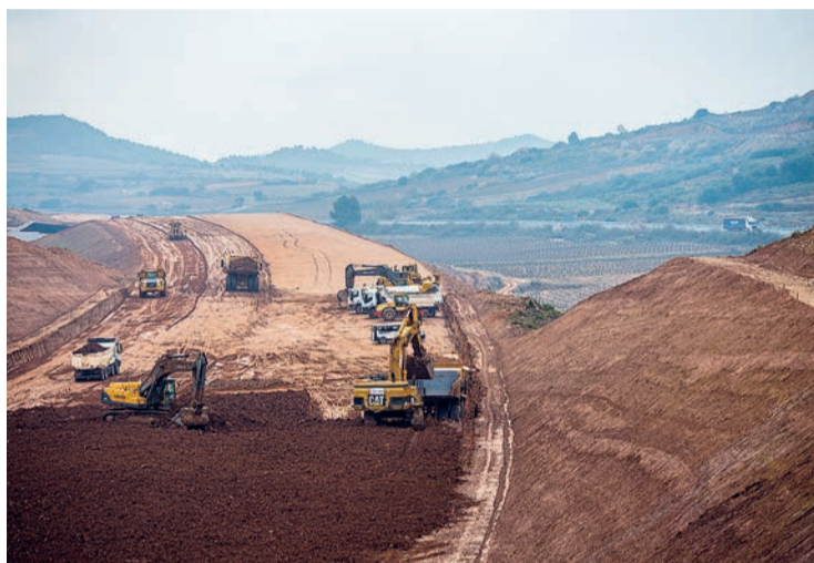
Trabajadores en las obras de acceso a la autopista A-68 en las afueras de Navarrete.
