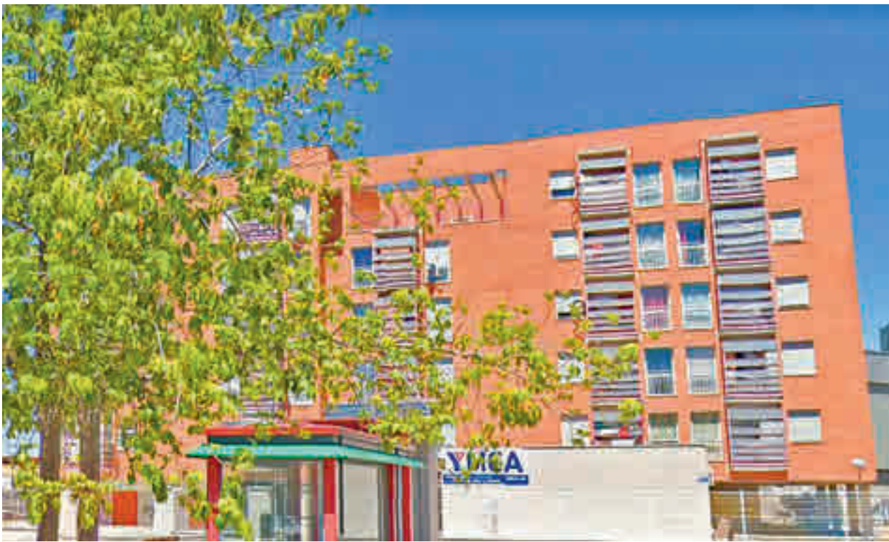
Imagen del edificio de viviendas de la avenida de las Ciudades
