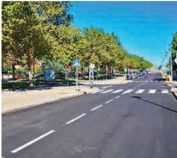
Uno de los viarios, cuyo asfalto ha sido ya renovado
