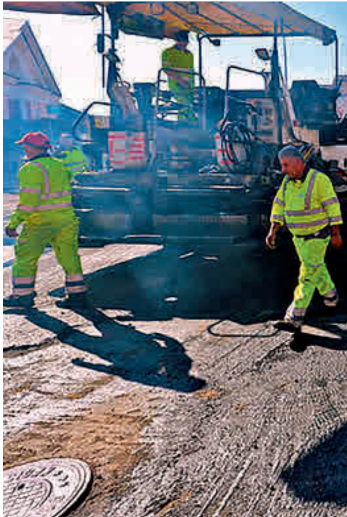
Imagen de unas obras de asfaltado de Coslada AYTO. COSLADA
