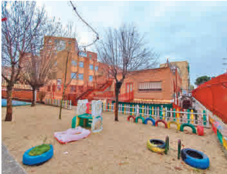
Edificio en el que se instalará el centro de refugiados
