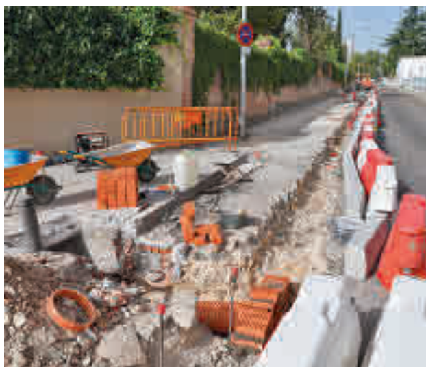
Las obras en el entorno del colegio Sagrado Corazón
