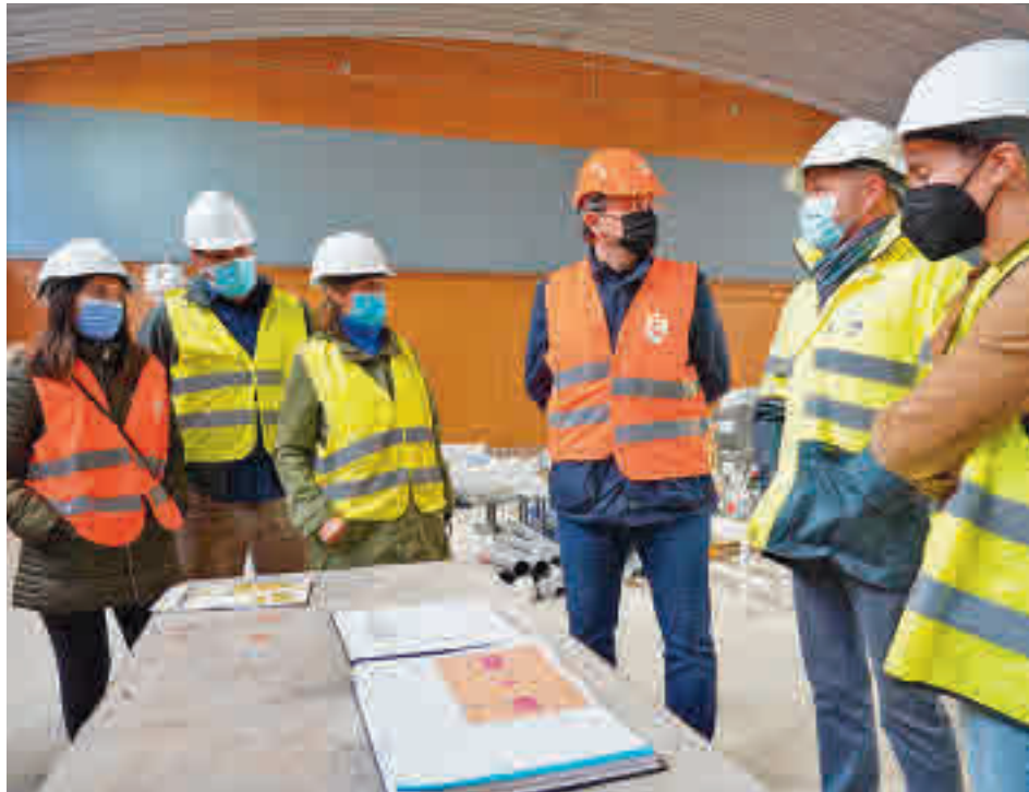
El concejal de Deportes, Ángel Buenache, durante la visita a las obras
