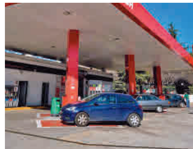
Gasolinera en la Comunidad de Madrid
