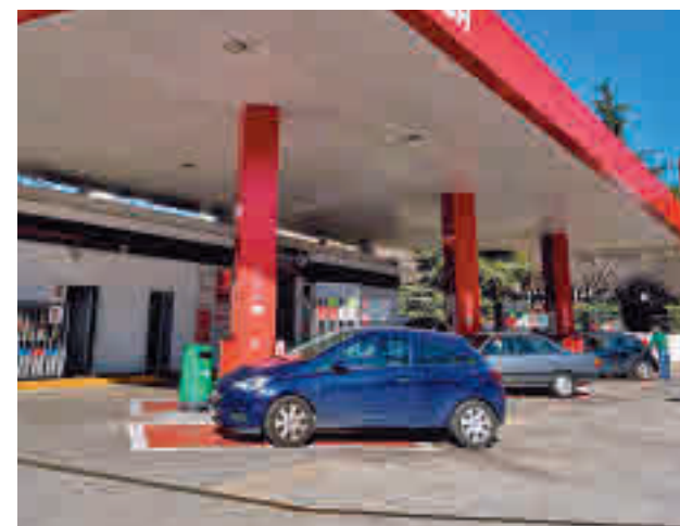
Gasolinera en la Comunidad de Madrid
