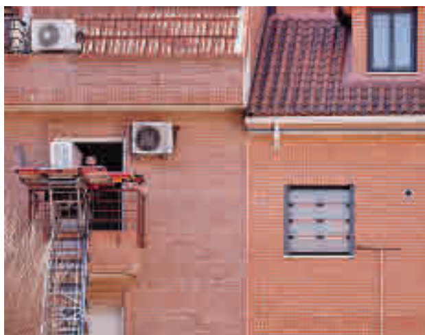
Trabajos en uno de los edificios afectados E.P.
