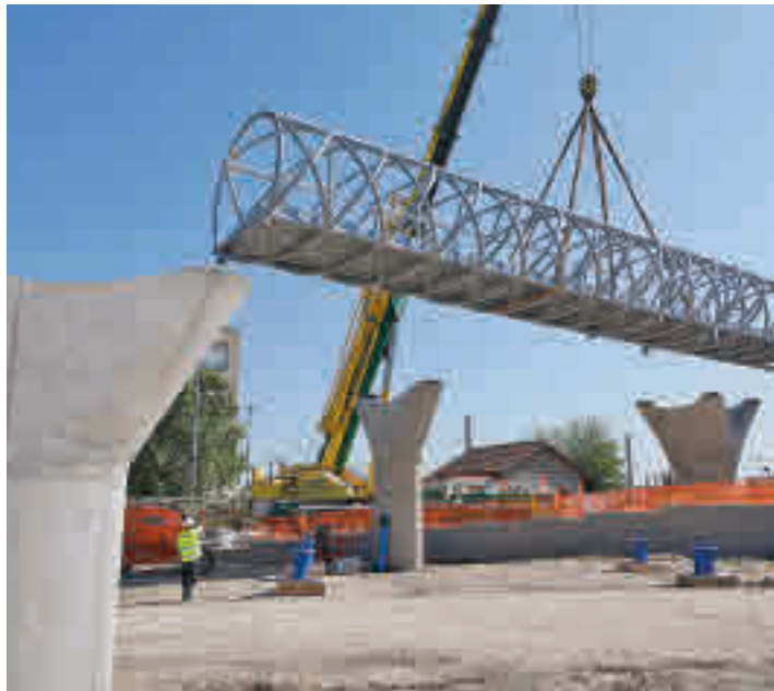
El izado del primero de los seis tramos de la nueva estructura
