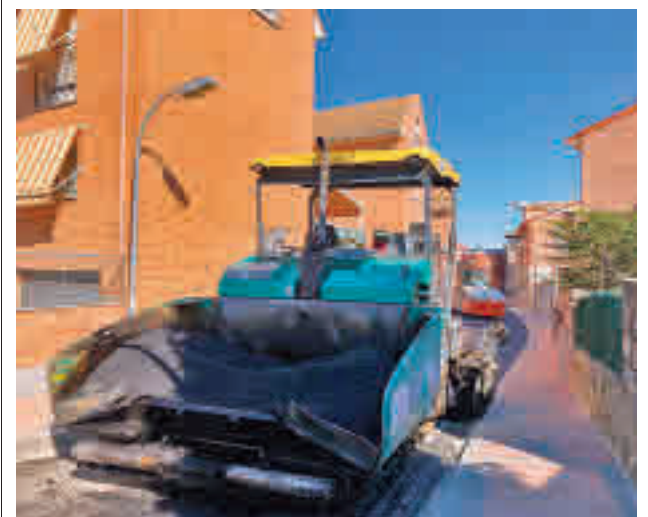
Los trabajos de asfaltado vuelven a la localidad
