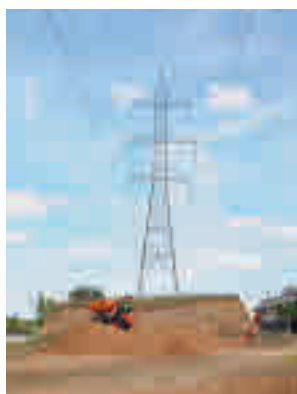
Las obras en una de las torres
