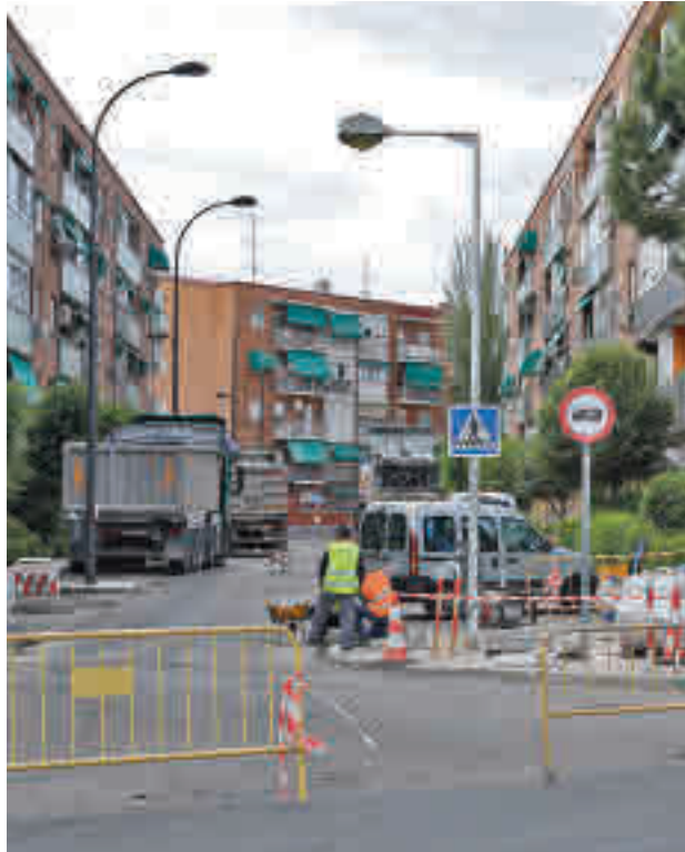
Primeros trabajos de la operación asfalto
