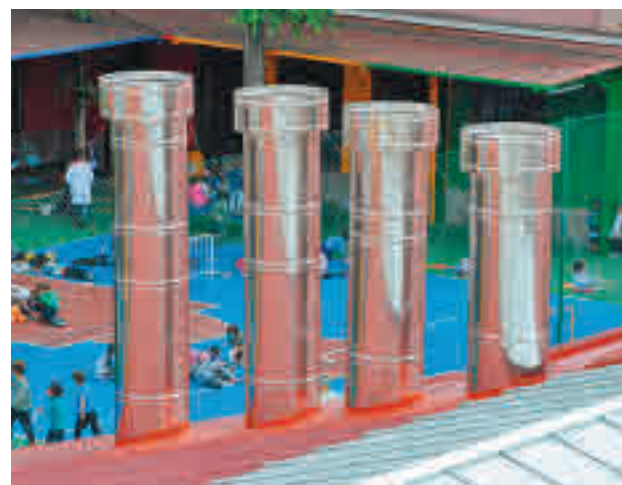
Las chimeneas situadas junto al centro escolar FRAVM
