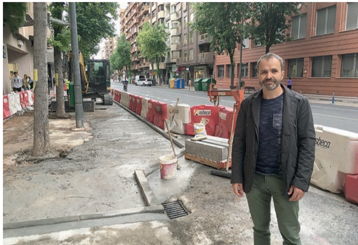
Jaime Caballero, en el nuevo paso peatonal de Vara de Rey.
