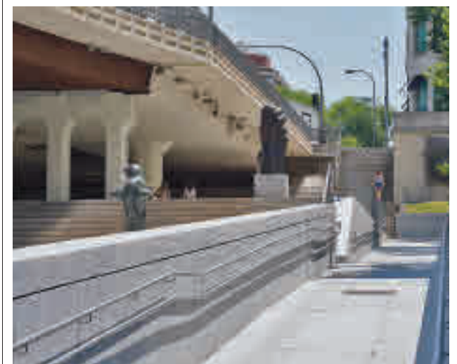
El museo, tras la finalización de los trabajos
